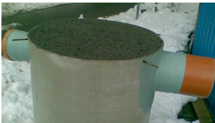
Slika1: Prikazano betoniranje prostora pod muldo
